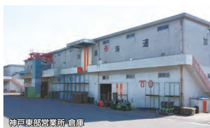
神戸東部営業所 倉庫
