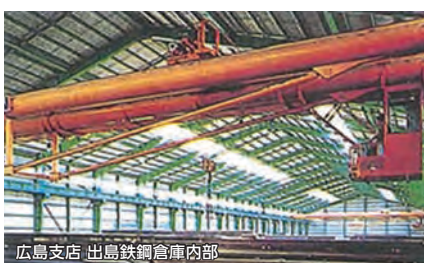
広島支店 出島鉄鋼倉庫内部
